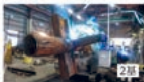
柱大組立溶接ロボットシステム
