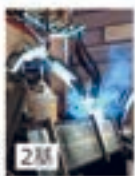
鉄骨コア（サイコロ）連結溶接ロボットシステム
